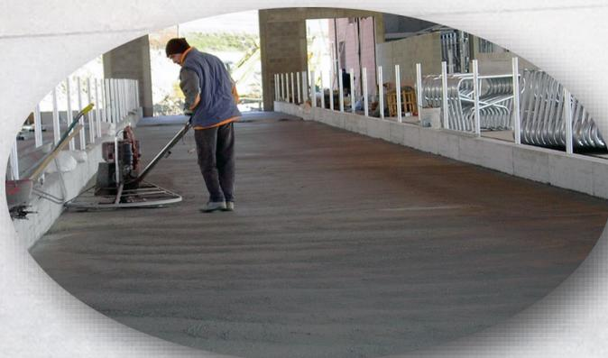
La realizzazione tramite elicotteri con pale liscianti
